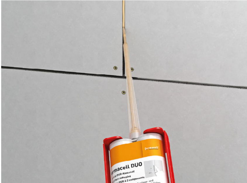
Nachträgliches Verkleben mit fermacell™ DUO Kleber
